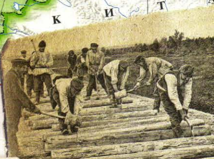
Зарубка шпал балдушками и топорами
