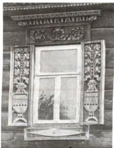
Наличник и ставни в технике глухой (корабельной) резьбы
