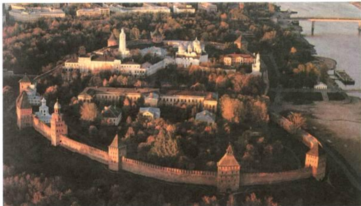
Новгородский кремль. Вид сверху
