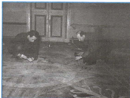
Восстановительные работы: разборка фрагментов золочёной резьбы и реставрация уникального паркета
